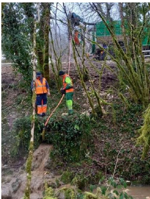
Suite aux pluies torrentielles du printemps, le ruisseau des Fosses est sorti de son lit. La raison de ce débordement venait du fait qu'un morceau de bois obstruait le conduit sous la route. L'écoulement ne pouvant plus se faire par le conduit, l'eau de ruissellement a endommagé la route départementale D91B.
