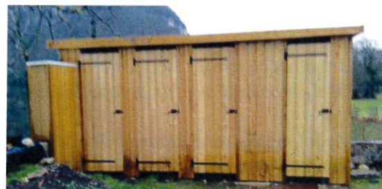
Portes en bois fabriquées et installées par notre employé communal Jean-Pierre
